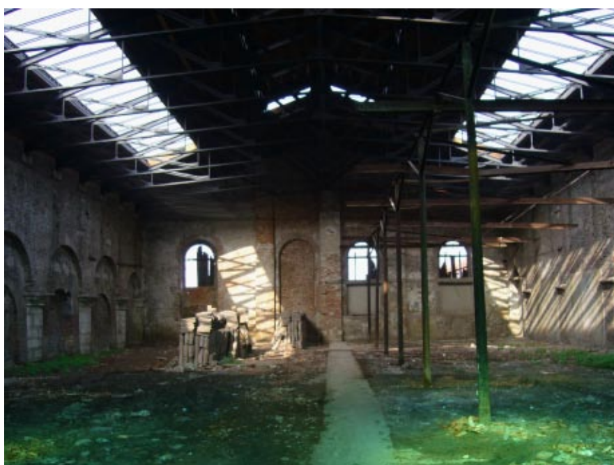
Tese di San Cristoforo – prima dei lavori
